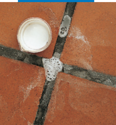
Pulizia di efflorescenza
