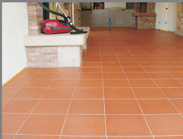
Il salone con il pavimento appena ultimato il trattamento
