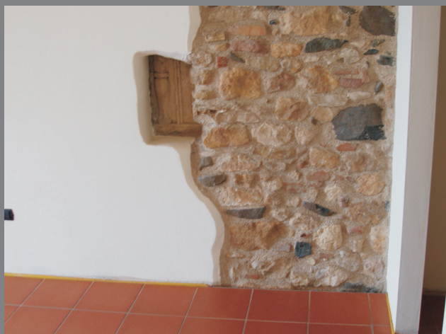
Particolare della parete in pietra conservata, ristrutturata e trattata.
