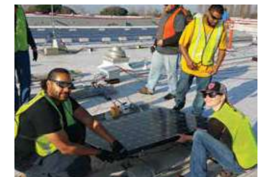
Il lavoro di squadra sui tetti
