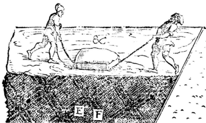
4. G.A. Rusconi, Della Architettura , Venezia 1590, p. 99, particolare. Levigatura del terrazzo operata con l'orso.
